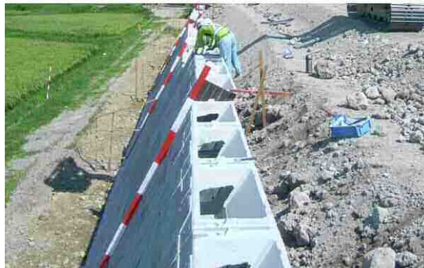
水平ブロック55型、ブロック積み上げ時状況
