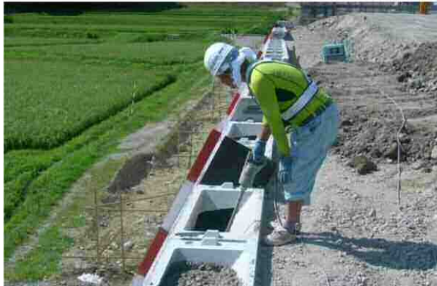
施工写真(間詰めコンクリート作業、ブロック布設)
